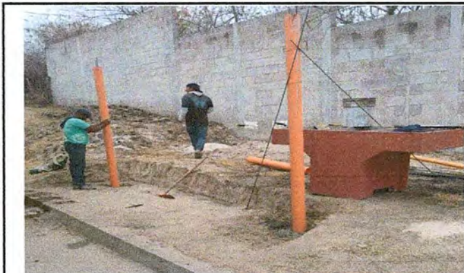
Foto 1: Instalación de bases para techado de estación de lavado de manos.
