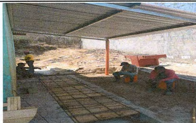
Foto 2: Fundición con drenaje para la plancha y colocación de la pila para estación de lavado de manos.
