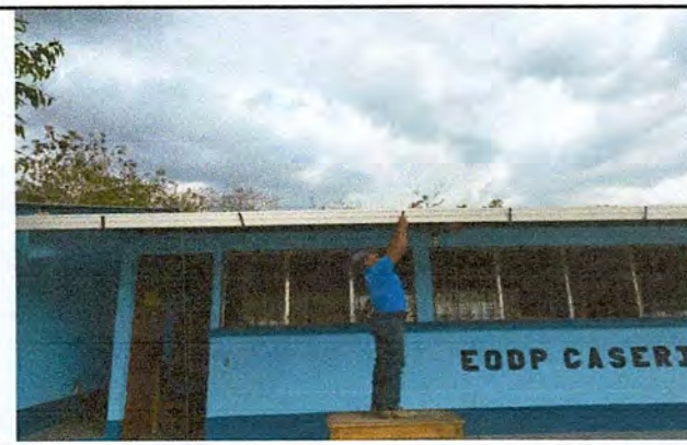
Foto 4: Instalación de canales para la recepción de agua pluvial, en los módulos de preprimaria.
