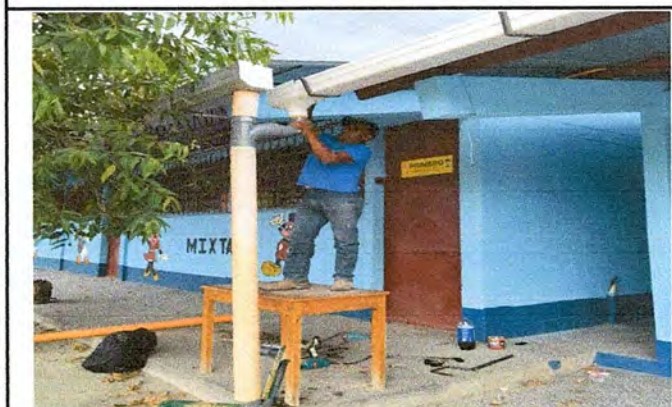
Foto 3: Instalación de bajada de agua de los canales del corredor de módulos de preprimaria.
