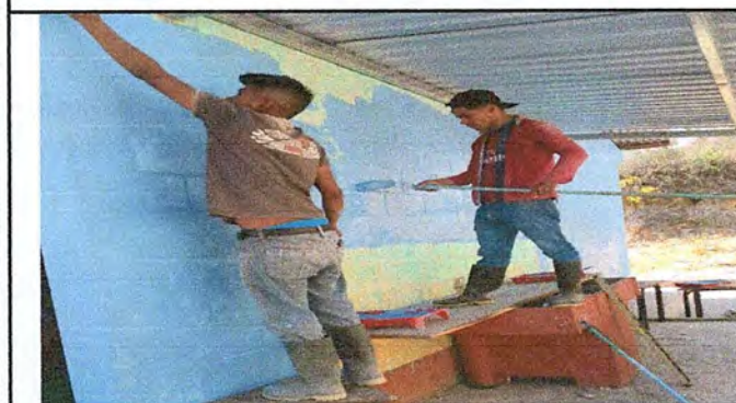
Foto 5: Remoción de pintura en el lado exterior de los módulos de preprimaria.
